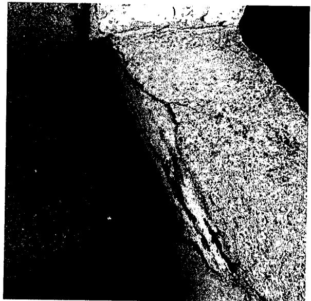
Foto N° 20: Murete escalera exterior edificio S1.
